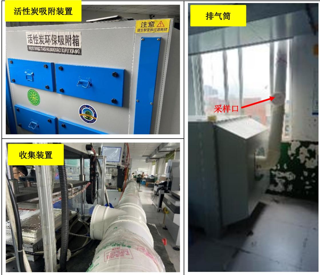
图 3-2 项目点胶、热压废气环保措施
