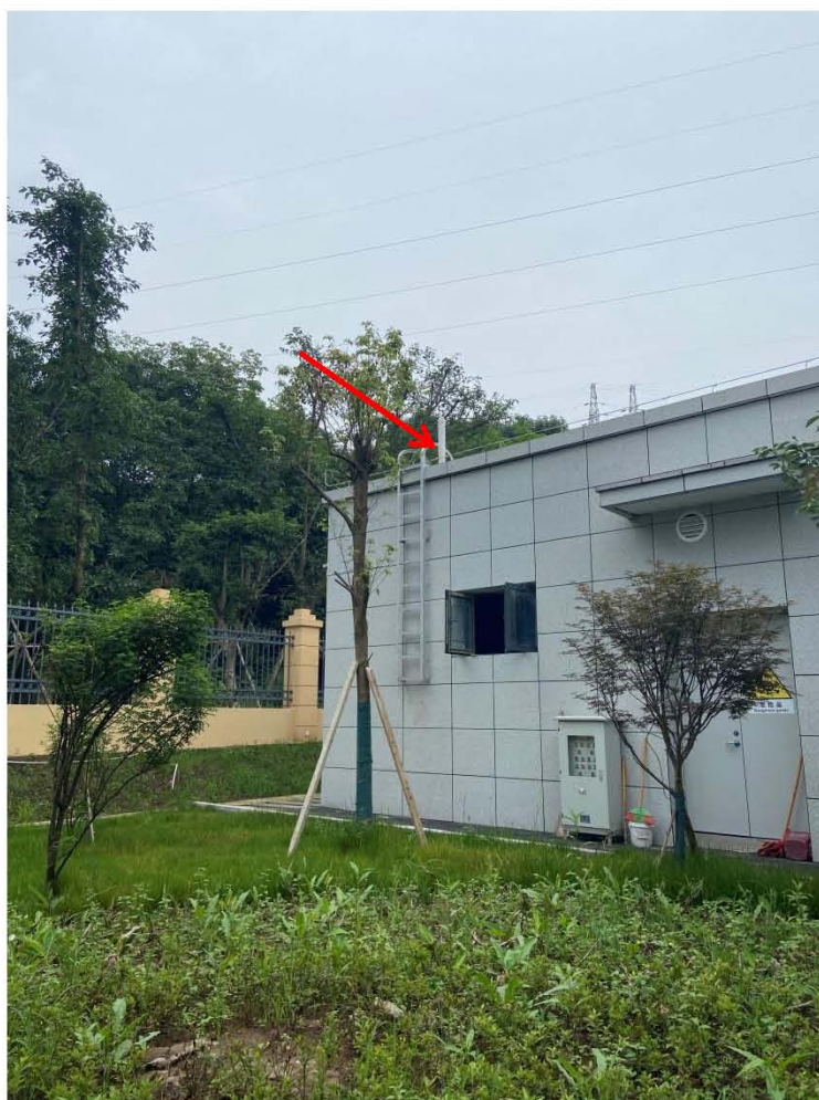
图 3-4 项目污水处理站臭气排气管
